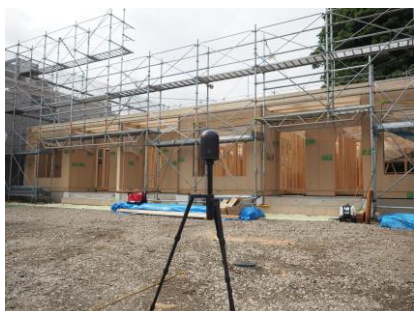
3D スキャナで施工現場を読み込み
