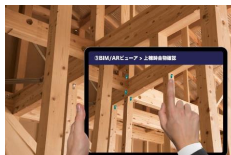
開口の位置や間柱・金物の正確な配置がスケルトンに表示されます。
